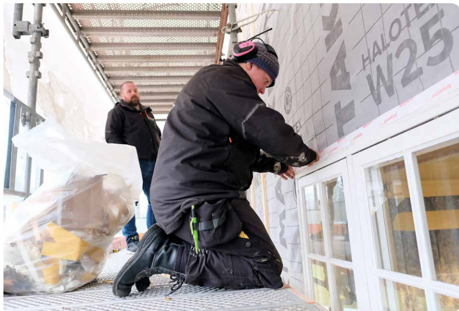
Tømrerlærling Ole Viktor Blekken taper skjøter på fasaden til det gamle kommunehuset på Mysen. Stian Stenseth følger fornøyd med.
