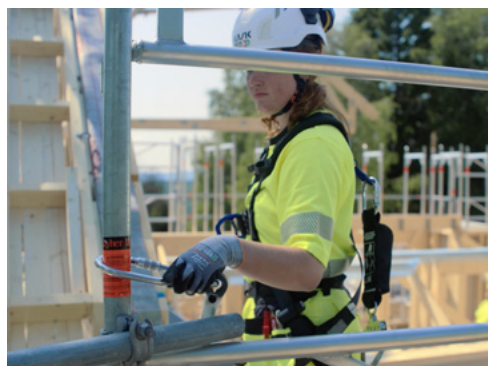
Fallforhindrende line kan festes i vertikal stillasstolpe/ramme
