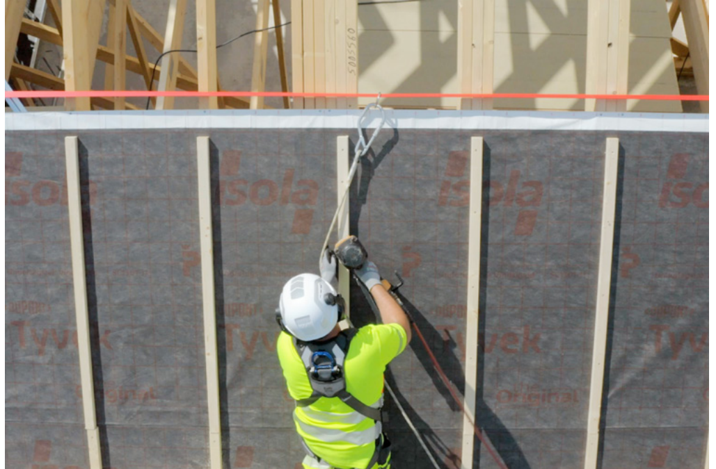
Bruk av horisontal sikkerhetsline
