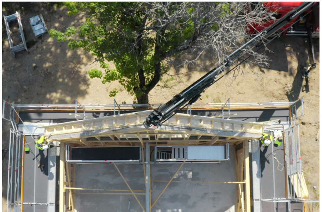
Gavlvegg med innvendig og utvendig stillas
