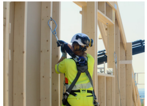
Hvis det ikke er rekkverk skal det brukes fallforhindrende line i godkjent feste
