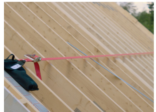
Horisontal forankringsline fra møne til møne
