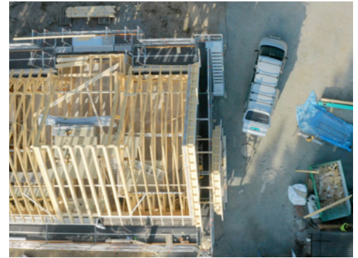
Start alltid fra raftet og arbeid deg opp mot mønet
