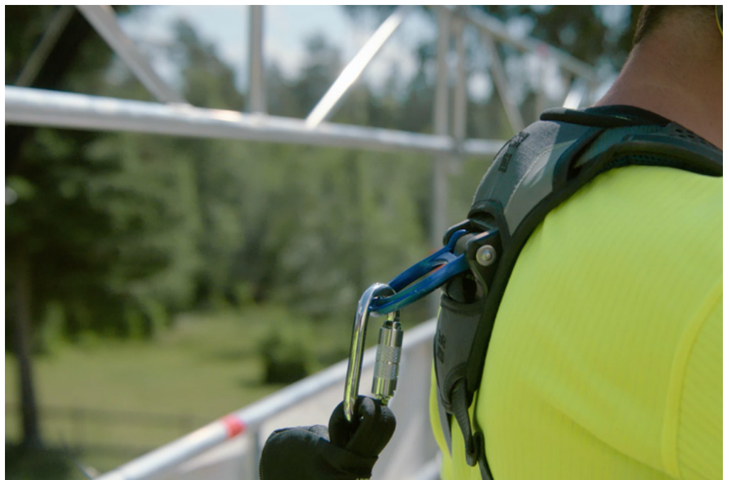
Bruk av horisontal sikkerhetsline
