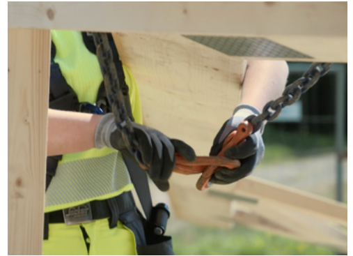
Montering av firepart kjetting
