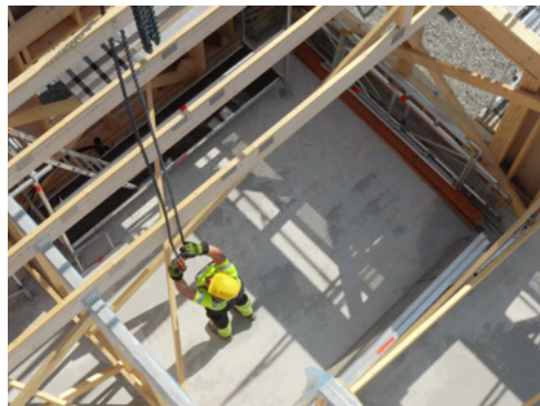
Demontering av firepart kjetting
