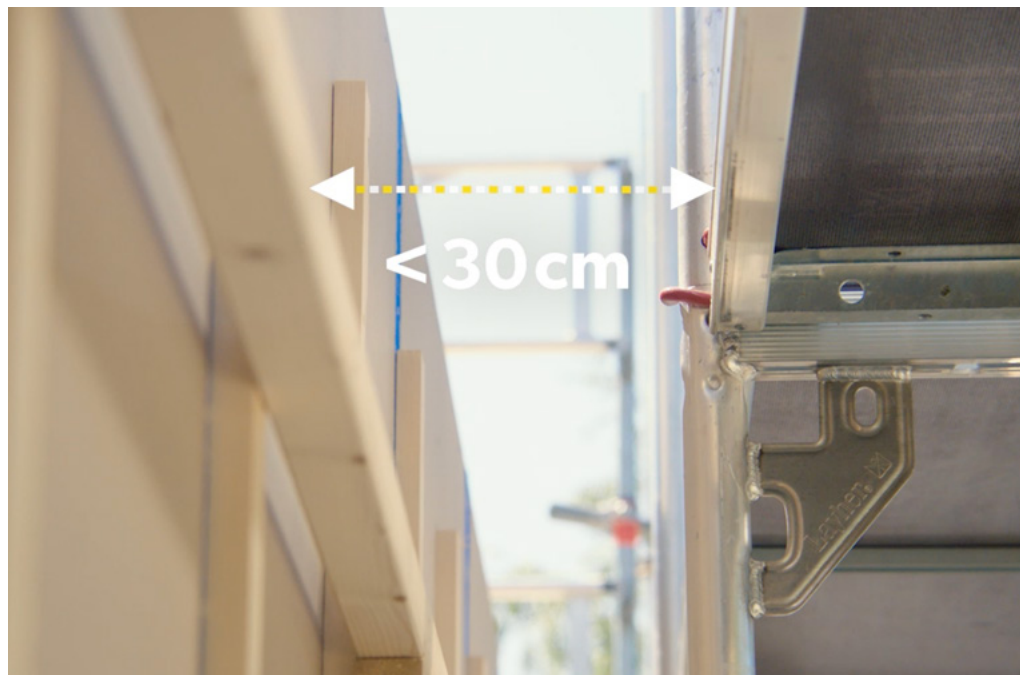
Avstand til stillasgolv mindre enn 30 cm
