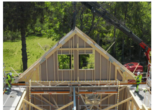
Bruk fallforhindrende line og innvendig stillas
