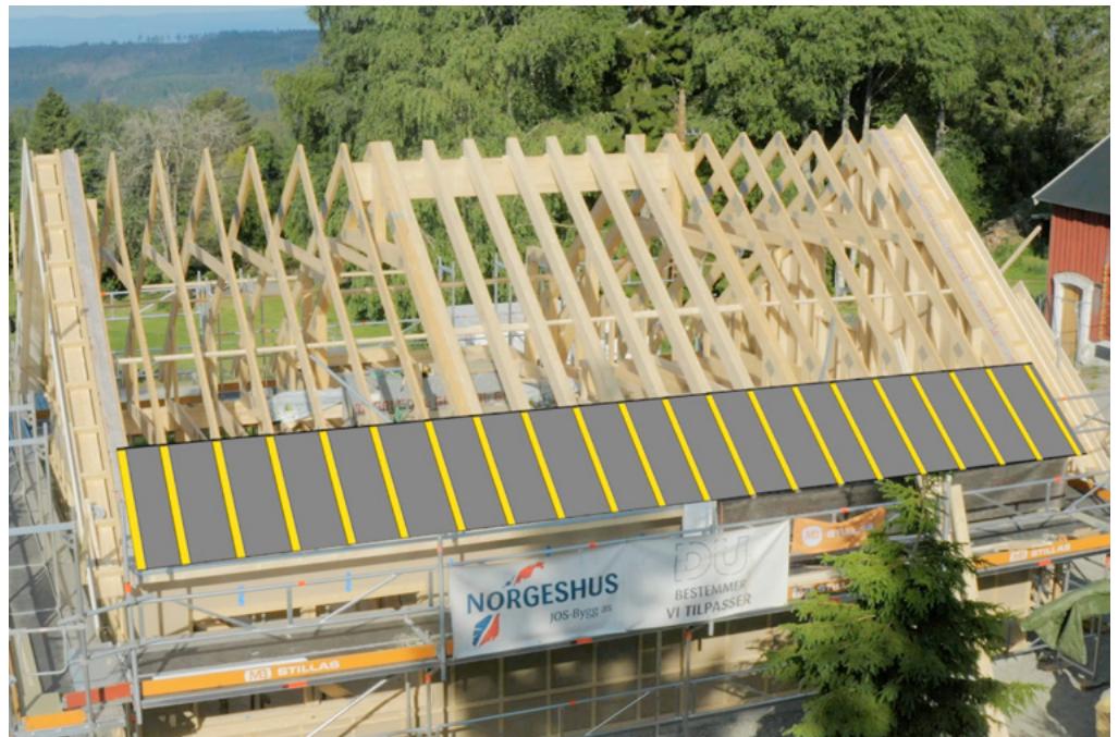
Det anbefales gjennomtråkksikker duk ved legging av dukprodukter
