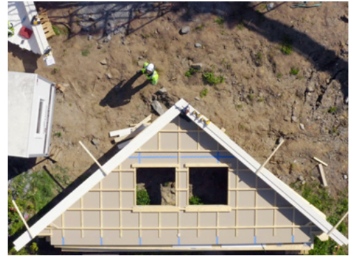
Gavlvegg mest mulig ferdig på bakken
